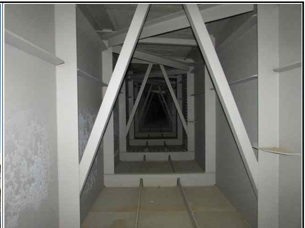
강재 거더 내부 상태양호
