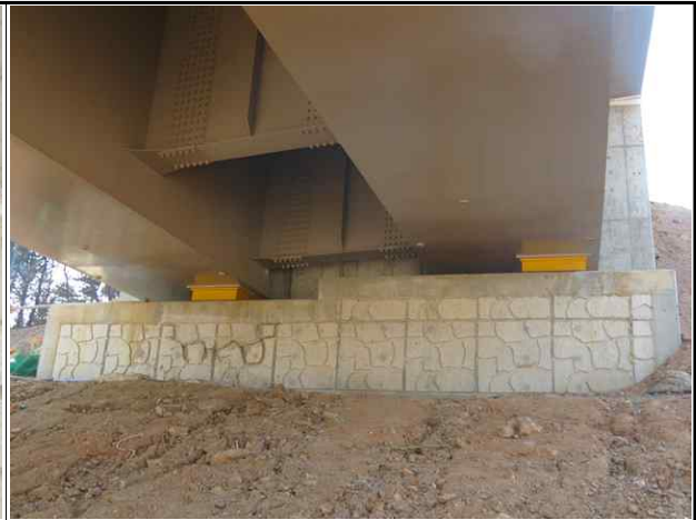
교대 A2 전경
