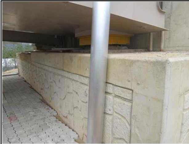
교대 A1 전경
