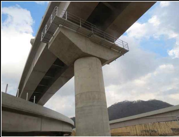
교각 P1 전경
