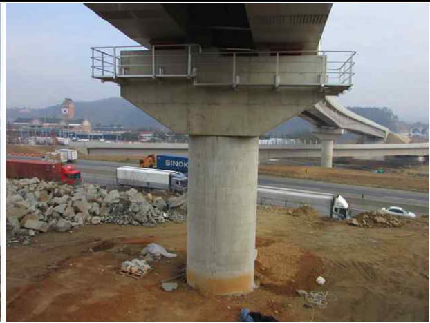
교각 P2 전경
