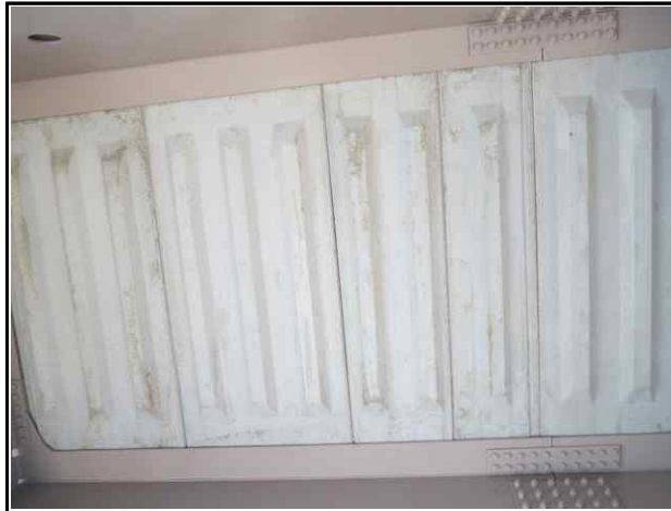
바닥판 중앙부 Rib Deck 상태양호
