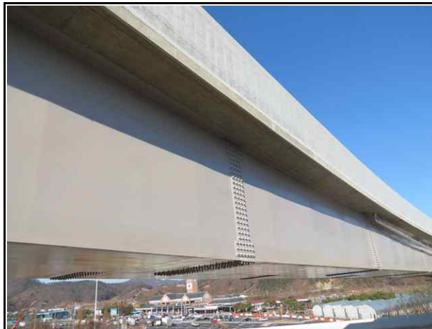
강재 거더 외부 상태양호
